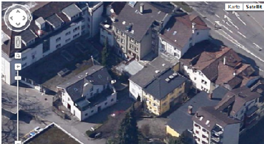
Talhofstraße, 9000 St. Gallen
